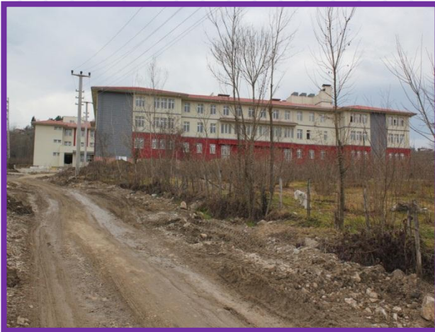
Resim 2-Güzel Sanatlar Lisesi Yapımı
