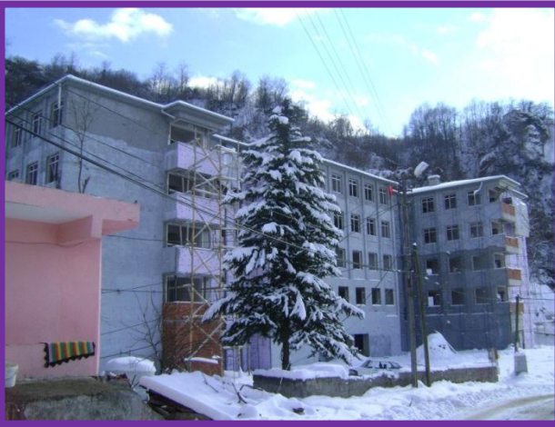
Resim 1-Kabataş Lisesi İnşaatı
