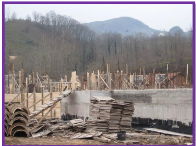
Resim 4- Çatalpınar Lisesi İnşaatı
