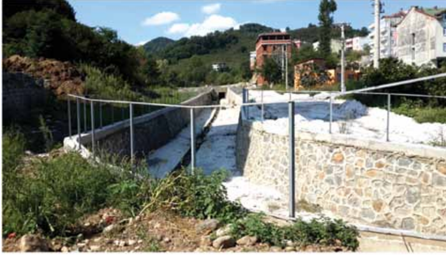
Fatsa (Ordu) Taş Duvar Dere Geçiş İnşaatı
