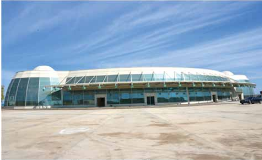
Ünye (Ordu) Otogar İnşaatı
