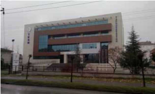
2013 yılsonu itibari ile yeni hizmet binamız tamamlanarak hizmete açılmıştır.
