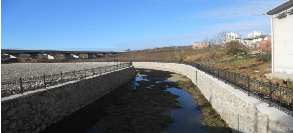
Fotoğraf 2 Ordu Altınordu Karacaömer Mahallesi Taşkın Koruma Tesisi
