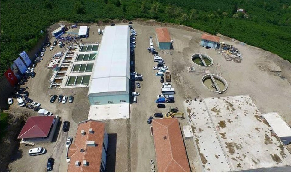
Fotoğraf 1 : Ordu İçmesuyu Arıtma Tesisleri Genel Görünümü
